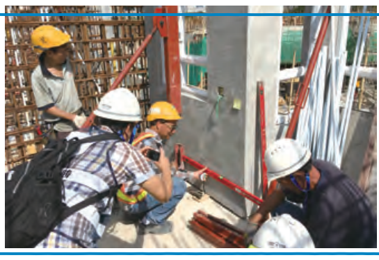
在地盤檢測建築結構
