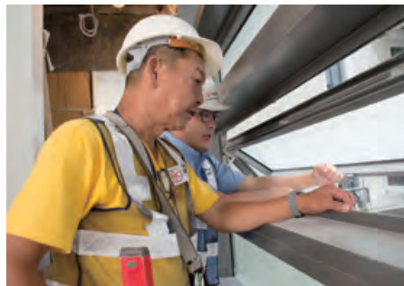
地盤員工在檢查建築質素
